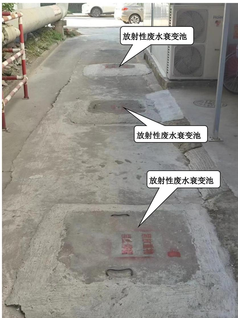
图4.3-2 公司放射性废水衰变池外观图
